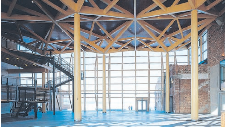
Lahden Sibeliustalo on suurin puurakennusprojekti Suomessa sataan vuoteen. Talon kymmenmetriset ja alaosaltaan 700 millimetriä halkaisijaltaan olevat valtavat pylväät edustavat Sorvi-Pojat Oy:n referenssikohteiden kärkeä.
